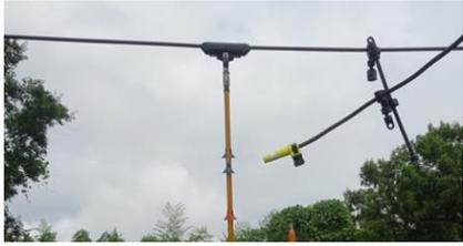
⑧分岐スリーブカバーを取り付けし、粘着性ポリエチレンテープで養生する。
