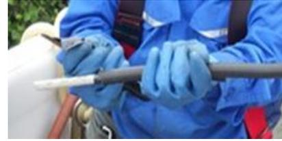
①接続する縁回し線の端末被覆を剥ぎ取る。
