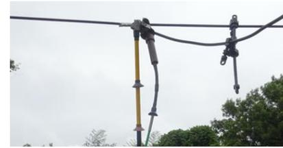
⑤ 分岐スリーブに近い位置で、縁回し線を切断する。
