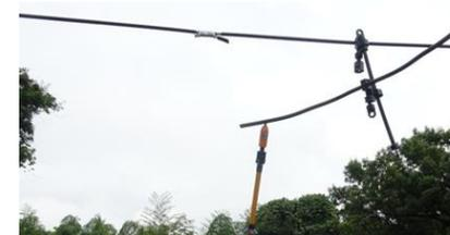
⑥ 切断した縁回し線の検電を行い、充電状態でないことを確認する。
