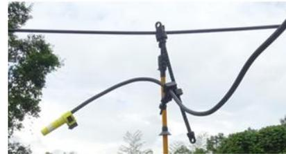
③接続相を確認し、仮支持具を幹線に取り付ける。
