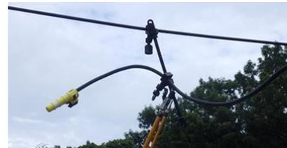
④把持部間隔を調整し、幹線と縁回し線を近づける。
