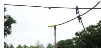
⑦ 切断した縁回し線に、端末キャップを取り付ける。
